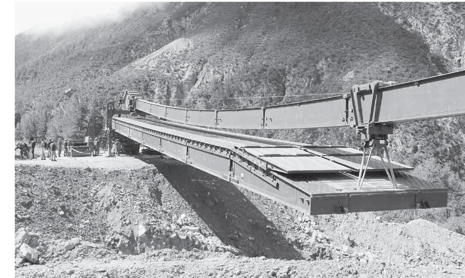
La construcziun massiva da la punt provisorica da l'Armada svizra porta fin 96 tonnas.
