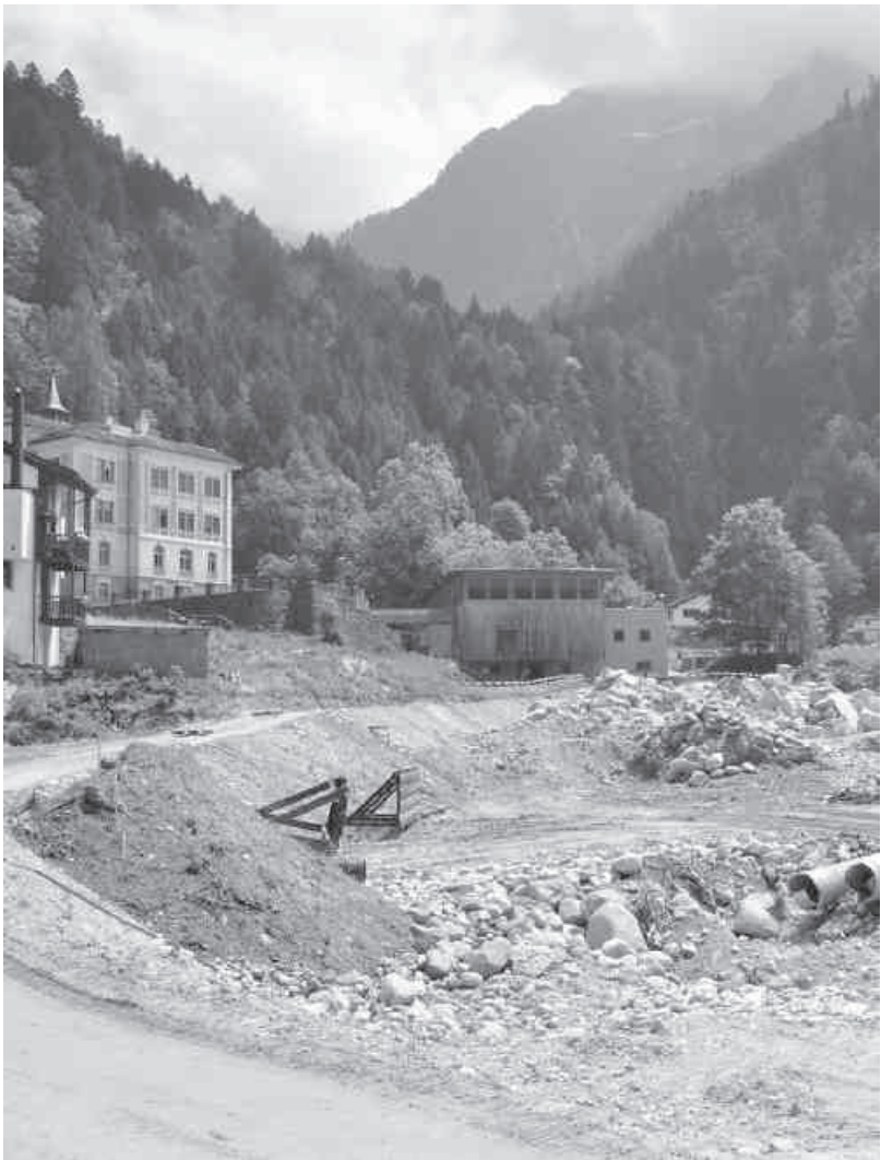
Rückhaltenbecken, Wuhren und Betonmauern sollen Bondo vor Murgängen schützen.
