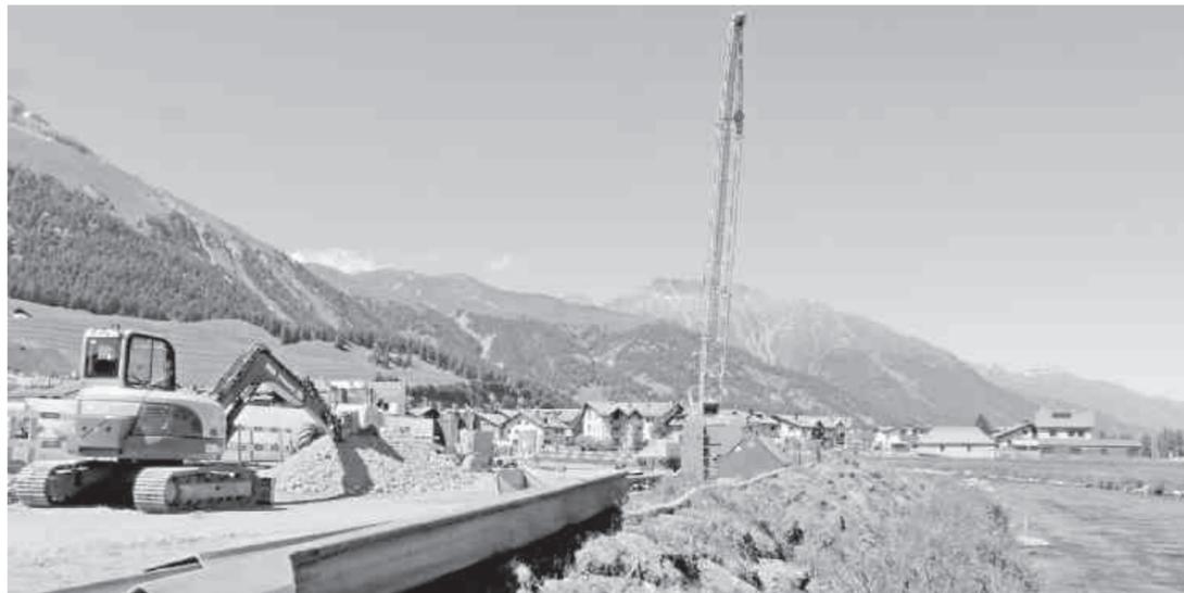
In Celerina wird zurzeit ein neues Abwasserpumpwerk gebaut. Die Baustelle verlangt aufwendige Baugrubensicherungsmaßnahmen.
