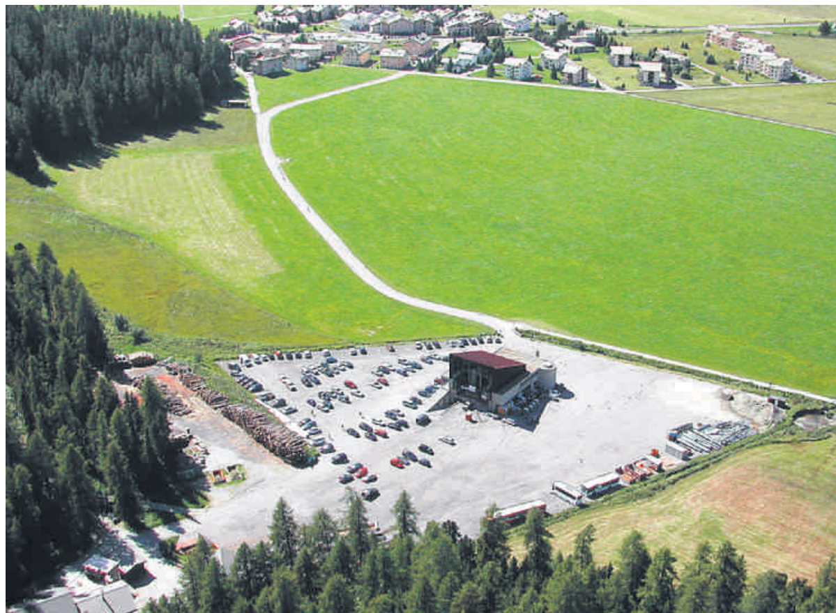
Für das Gelände der Talstation der Furtschellasbahn sind die planerischen Voraussetzungen zum Bau eines Hotels geschaffen worden.
