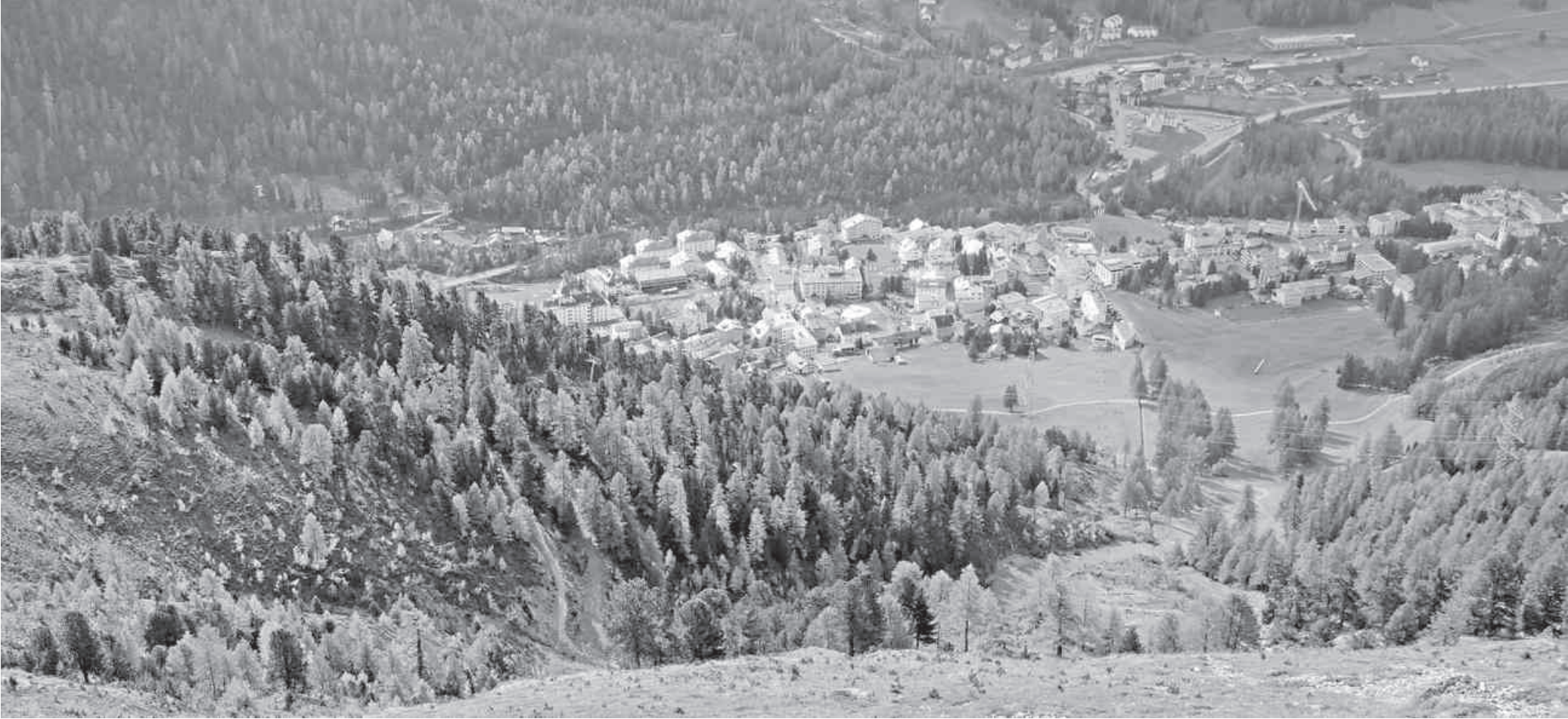
Der Gemeindevorstand von Pontresina erwägt den Neubau der privaten Werkleitungen im Quartier Truoch.
