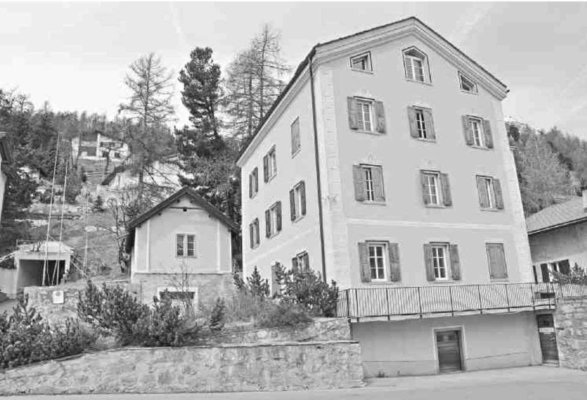
Hier an der Via Maistra in Silvaplana kann eine Baugesellschaft mit Einheimischen bald ihre Überbauung im Baurecht erstellen.
