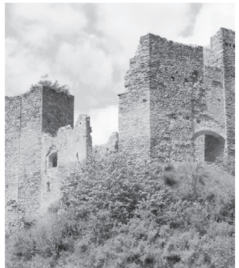
Die Burg Tschanüff nach der Sanierung. Zu sehen sind Baureste des 10. bis 16. Jahrhunderts. Foto: Archäologischer Dienst Graubünden, Jürg Goll
