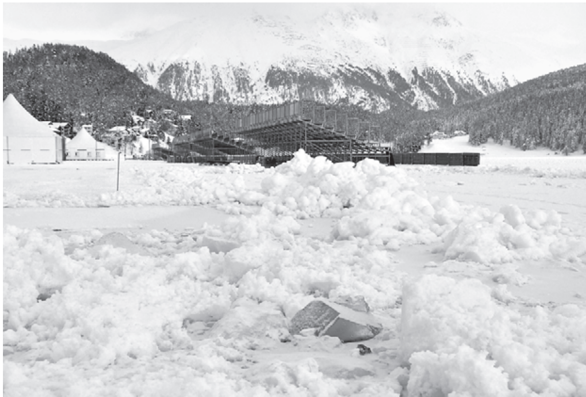
Erschwerte Bedingungen beim Aufbau der Infrastruktur auf dem St. Moritzersee.
