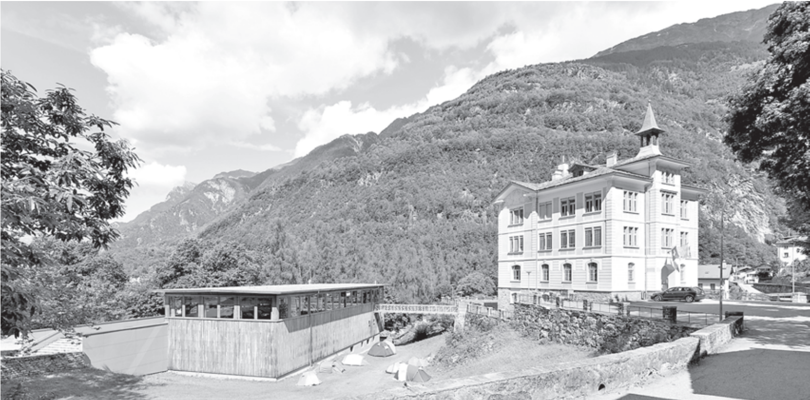
Eines der vom Schweizer Heimatschutz gerühmten Bergeller Beispiele: Das alte Primarschulhaus in Promontogno, heute Verwaltungsgebäude der Gemeinde Bregaglia, darunter die Mehrzweckhalle. Foto: James Blatten/Schweizer Heimatschutz
