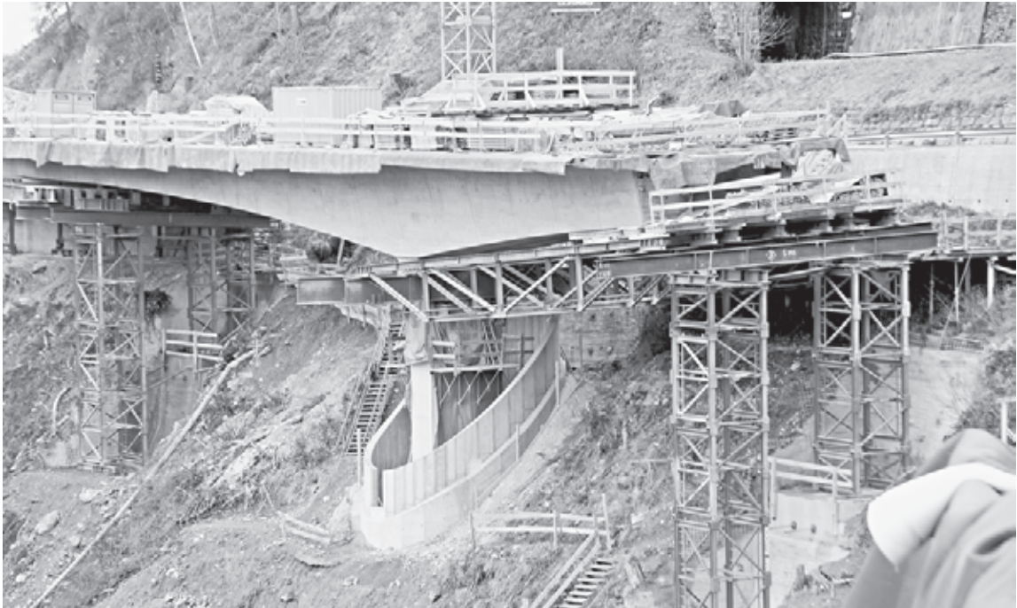
Lavuraints preparan las pozzas pella puntinada e l’armadüra da la prosm’etappa da la punt da Magnacun (schnestra). Raduond ün terz da quella punt chi pozza sün duos pilasters immez da duos tumbins gigantescs es gnü finì dūrant l’on scuors. fotografias: Jon Duschletta
