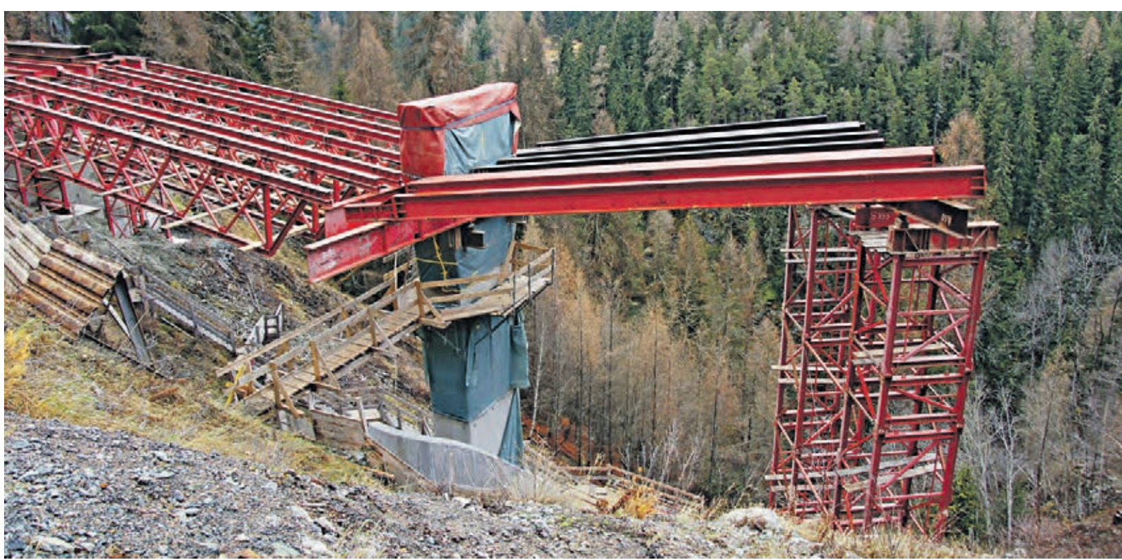
Auf dieses stählerne Lehrgerüst wird nächsten Frühling das eigentliche Brückengerüst und die hölzerne Betonschalung montiert. Läuft alles nach Plan, so zirkuliert schon in einem Jahr der Verkehr über die neue Magnacun-Brücke zwischen Garsun und Ardez. Foto: Jon Duschletta
