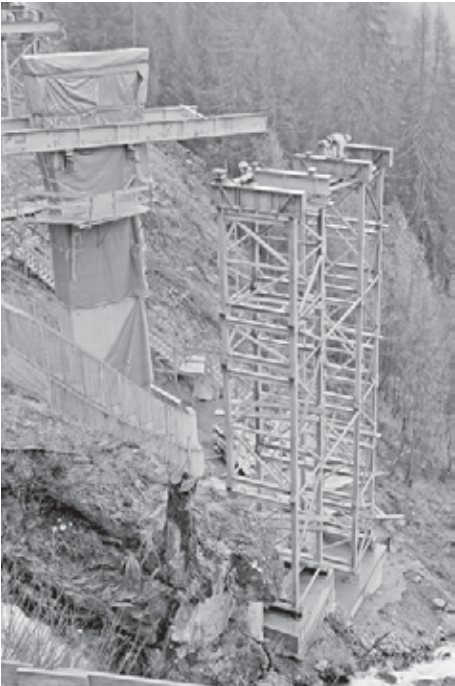
Lavuraints preparan las pozzas pella puntinada e l’armadüra da la prosm’etappa da la punt da Magnacun (schnestra). Raduond ün terz da quella punt chi pozza sün duos pilasters immez da duos tumbins gigantescs es gnü finì dūrant l’on scuors. fotografias: Jon Duschletta
