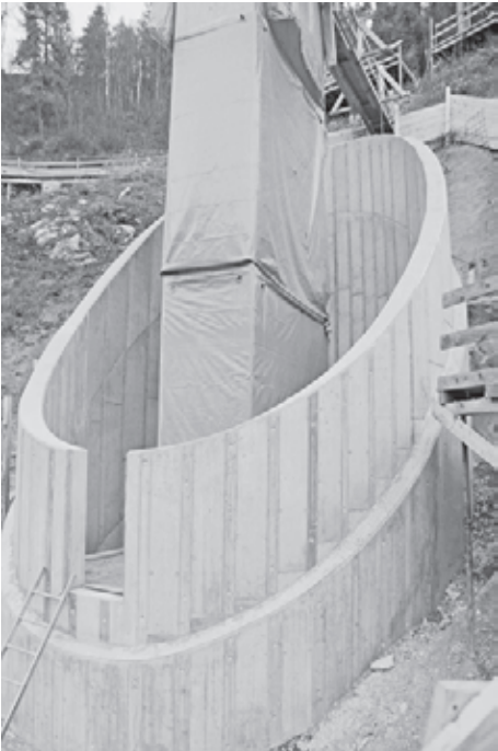
Lavuraints preparan las pozzas pella puntinada e l’armadüra da la prosm’etappa da la punt da Magnacun (schnestra). Raduond ün terz da quella punt chi pozza sün duos pilasters immez da duos tumbins gigantescs es gnü finì dūrant l’on scuors. fotografias: Jon Duschletta
