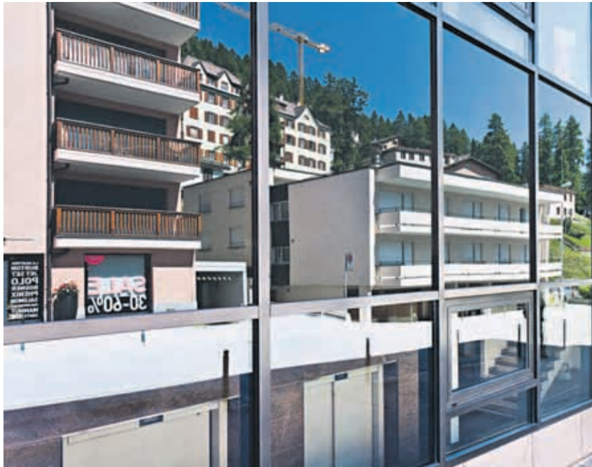
Eine Verbesserung des Ortsbildes und die Sicherung der architektonischen Qualität auf einem hohen Standard: Das sind Ziele der geplanten Gestaltungskommission.
