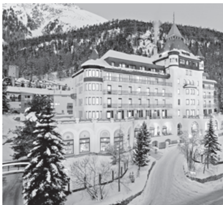
Das Hotel Walther in Pontresina ist einer von 22 Südbündner Betrieben, welcher beim Projekt «Leuchtturm» mit dabei ist.
