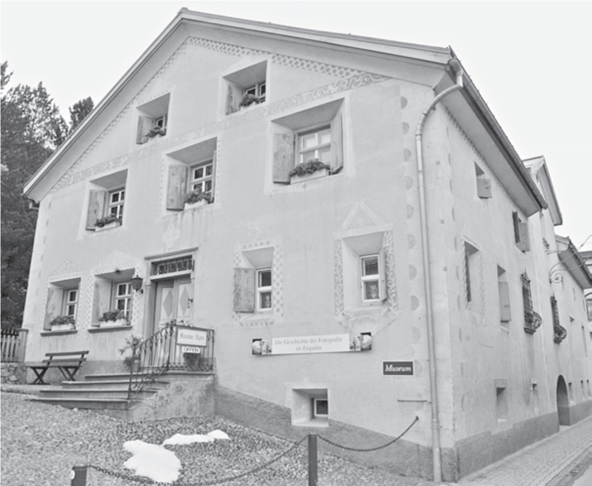
Gewisse Erneuerungsarbeiten im Pontresiner Museum Alpin konnten nicht wie vorgesehen schon 2014 erfolgen. Sie sind nun im Budget 2015 vorgesehen (Elektroinstallationen, Heizung, Beleuchtung). Foto: EP Archiv
