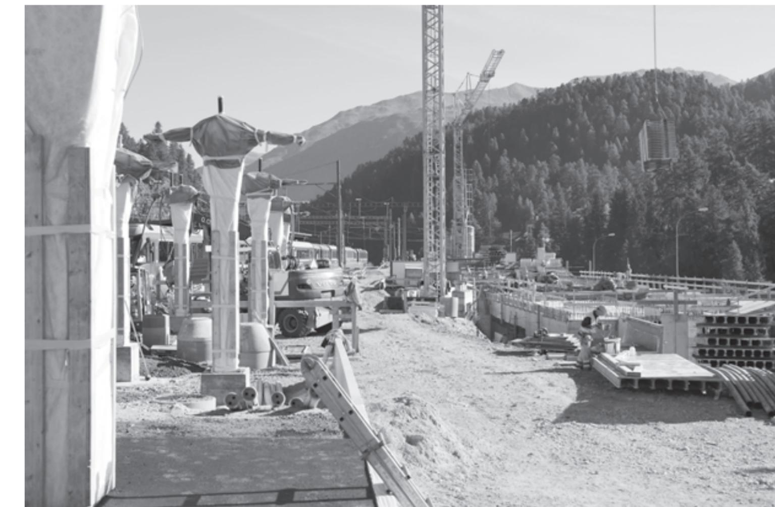
Wo jetzt nur einzelne Pfeiler stehen, wird im Sommer 2015 das neue Bernina-Perron gebaut. Die neuen Perrons sollen länger werden, um den neuen Zügen gerecht zu werden. Zudem sind die Perrons erhöht, damit die Zugwagen rollstuhlgängig sind.
