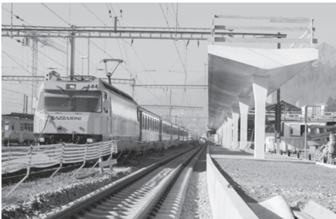
Im vorderen Teil von Gleis eins sind die Schienen bereits installiert. Die neuen Betonschwellen sind langlebiger als die früher verwendeten Holzschwellen.
