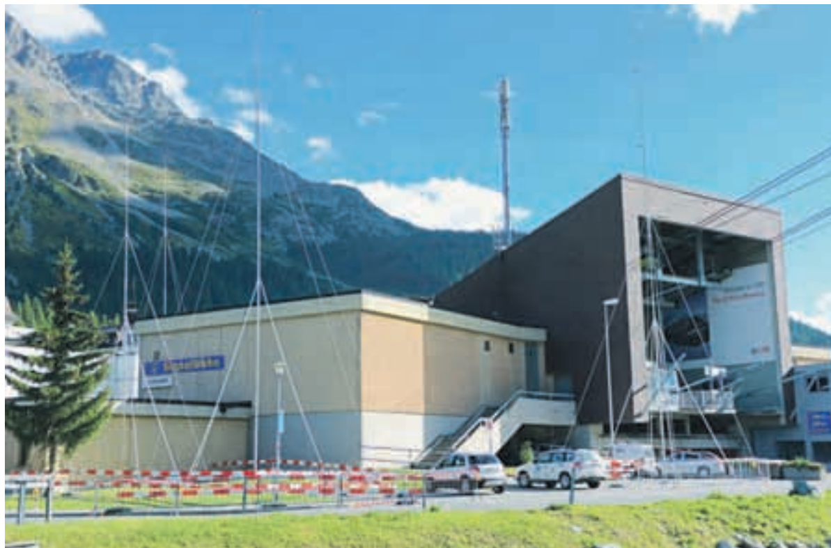
Die Profile sind gestellt, die alte Signalbahn soll bis in gut zwei Jahren durch eine Umlaufbahn ersetzt werden.
