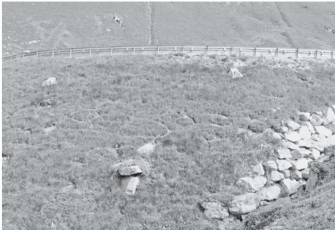
**Noch sind die direkt übertragenen Grassoden in der Strassenböschung teilweise erkennbar. Steilere Böschungsstücke wurden statt mit einer Betonmauer mit Blöcken aus dem Aushub gestaltet.**
