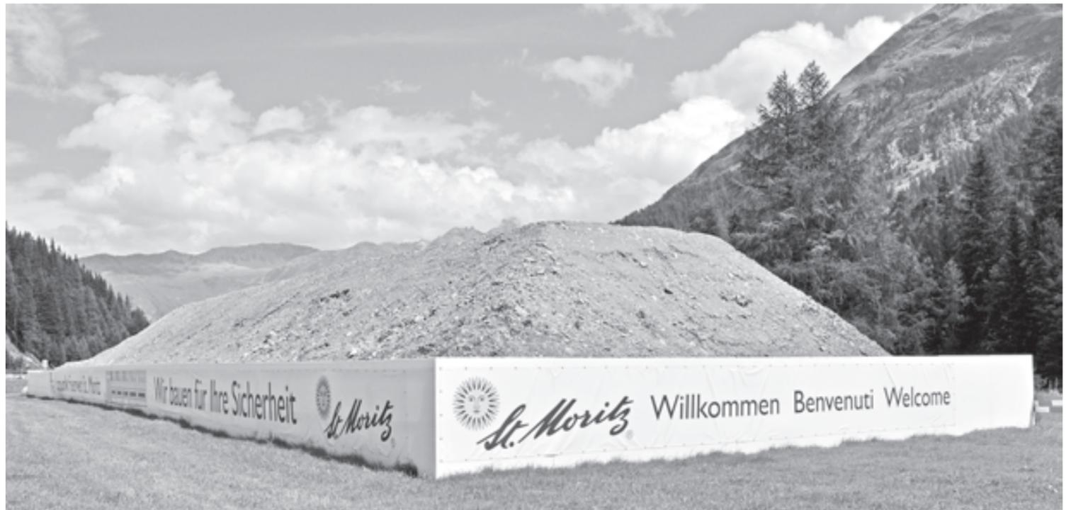
5500 Kubikmeter Material lagert auf dem Parkplatz bei der Olympiaschanze. Dieses Material wird gebraucht, um nach der Altlastensanierung die Baugrube für das Feuerwehrdepot Islas wieder zu füllen.
