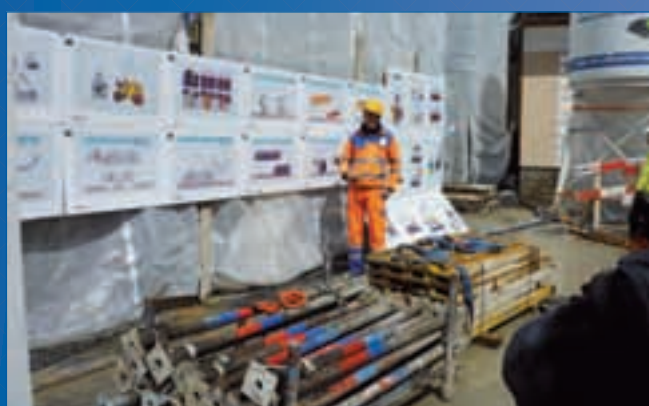
Kran: Anschlagen von Lasten
