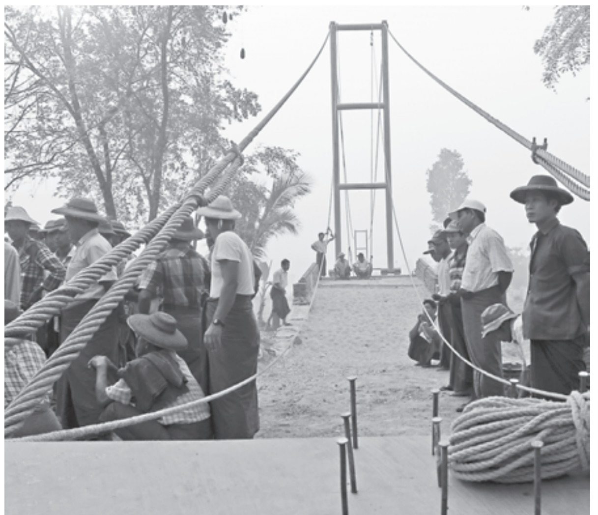
Kyar Bin, Sagaing. Der Brückenbau mit Hilfe von starken Bauernarmen.
