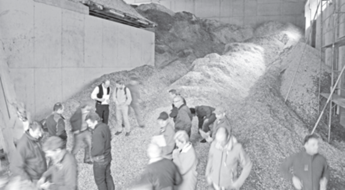
Begehbares Energiedepot. Bis 6000 m³ Holzschnitzel fasst die gedeckte Lagerhalle der Holzbaufirma Salzgeber in S-chanf. Gefüttert wird damit die betriebseigene Fernwärmanlage.
