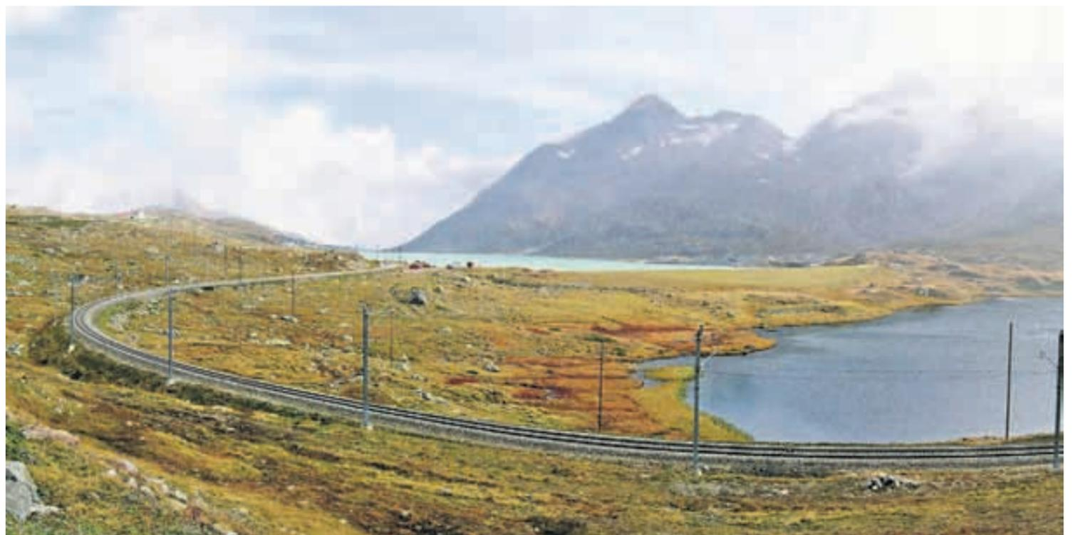
So soll nach der Erhöhung des Seespiegels um 4,35 Meter die Nordseite des Lago Bianco aussehen. Ohne Mauer, dafür mit einem begrünten Damm. Der definitive Bauentscheid beim Projekt «Lagobianco» wird allerdings erst nach der Detailprojektierung fallen.
