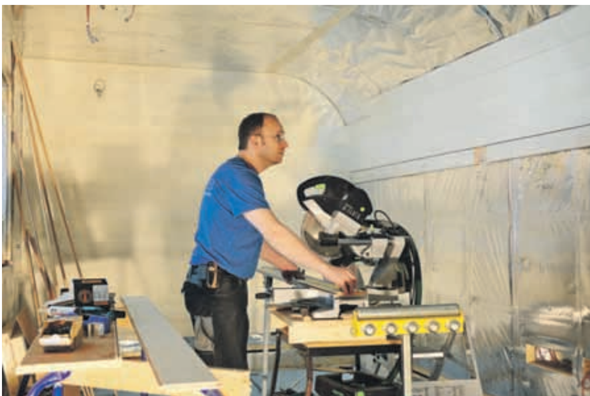
Die Saunas sind isoliert, zurzeit bekommen sie ihr Holzkleid – leicht weiss lasiertes Tannenholz.
