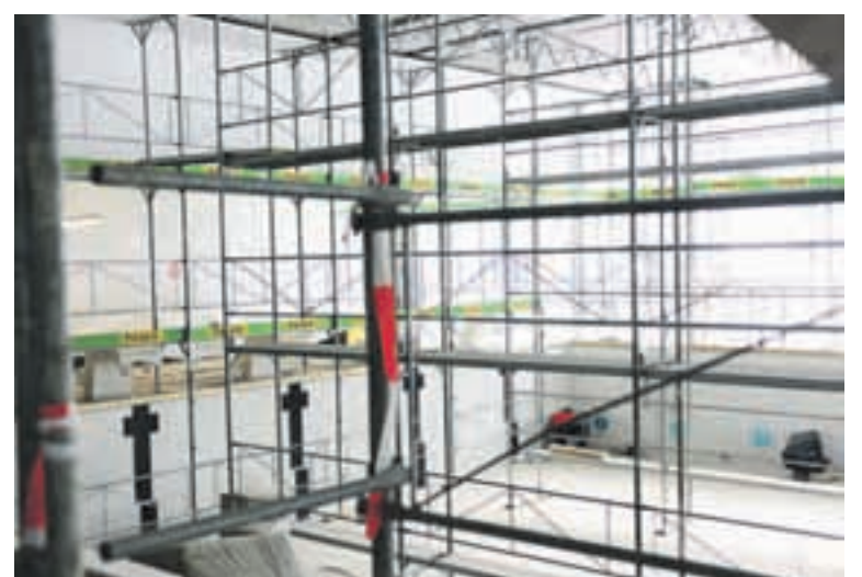
Die Gerüste zur Schallisierung der Decke werden diese Woche abgebaut.
