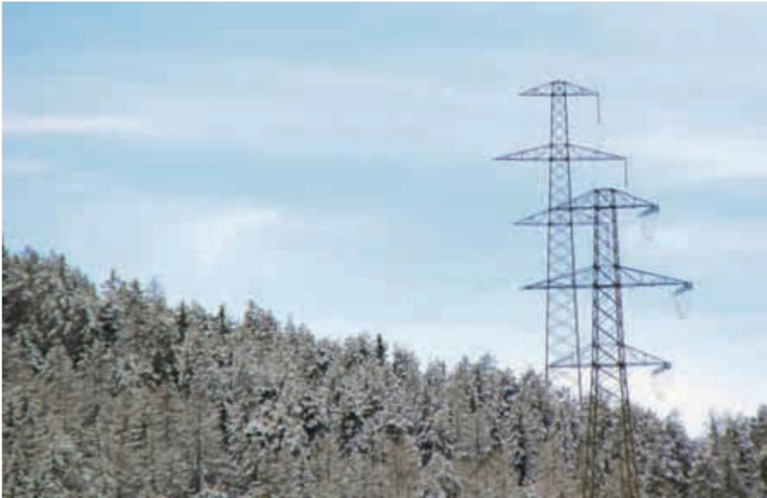
Die nur einseitig belegten Masten der 380-kV-Leitung zwischen Scuol/Pradella und La Punt Chamuesch sollen teilweise erhöht, aber vor allem mit einem zweiten Leitungsstrang aufgerüstet werden. Foto: Jon Duschletta
