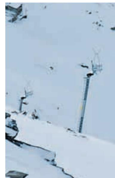
Lawinensprengmast der Firma Wyssen, der auch im Engadin eingesetzt wird.
