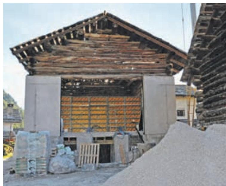
Stein des Anstosses: Einer der Ställe auf Isola, der zurzeit in Wohnraum umgebaut wird.
