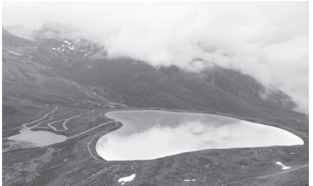
Der See beim See: Die Ansicht des neuen Naturspeichersees (links) mit dem Pumpwerk in der Dammkrone und dem heute bereits bestehenden Lej Alv. Modellbild: Engadin St. Moritz Mountains AG
