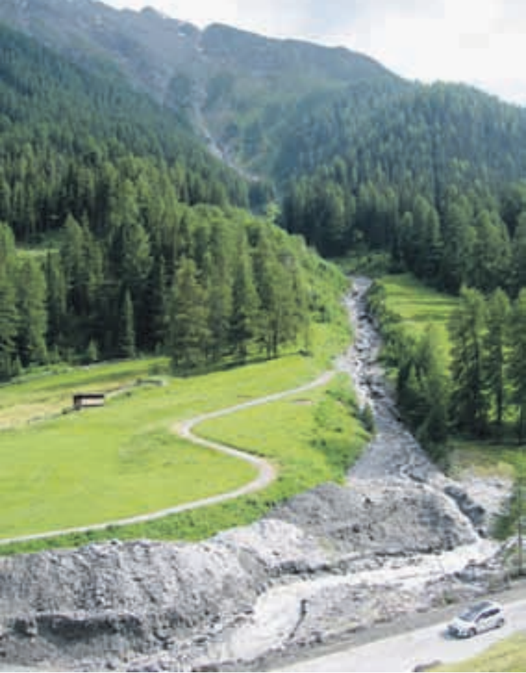
Murgang im Samnaun. Vier Bagger sind im Einsatz, um das Geschiebe im Planertal zu entfernen.
