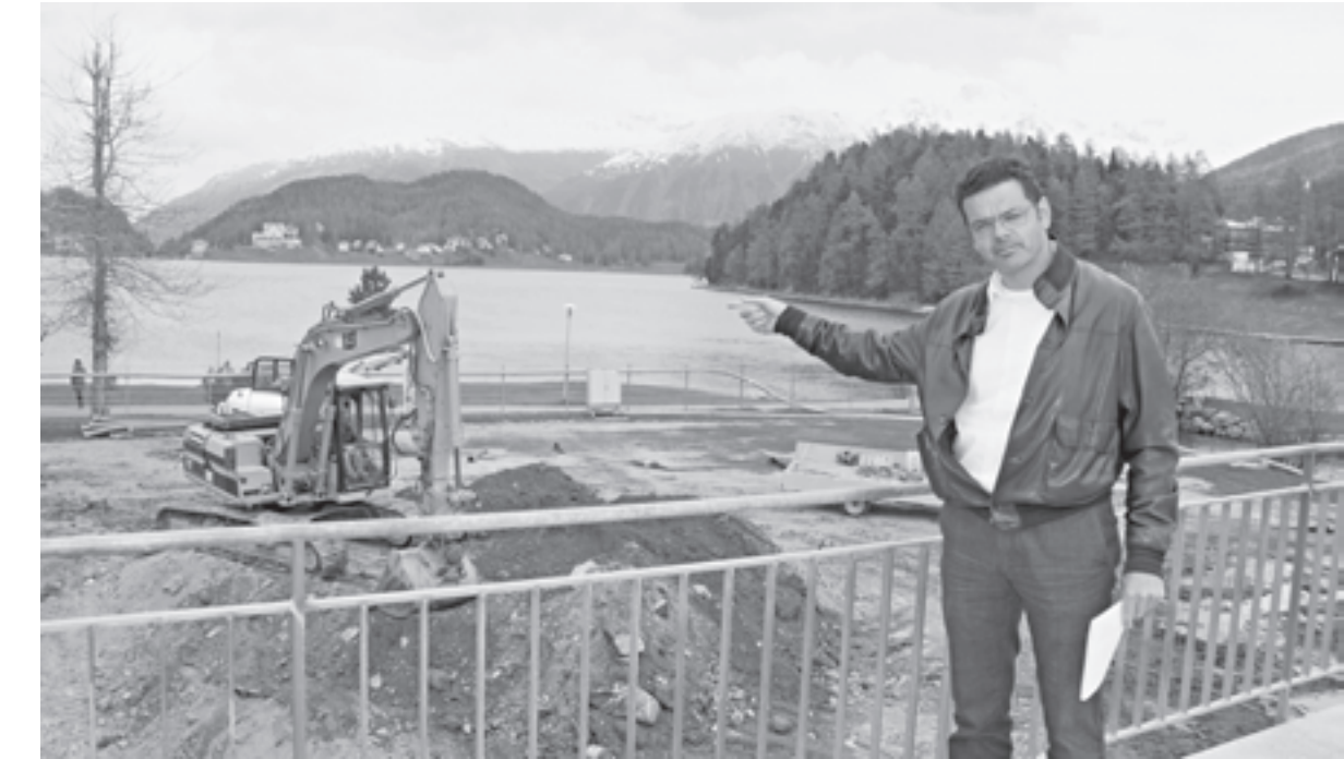
Patrik Casagrande, Leiter St. Moritz Energie, zeigt auf das Gelände des Natureisfeldes, wo die Bauarbeiten für die Wärmepumpe begonnen haben.
