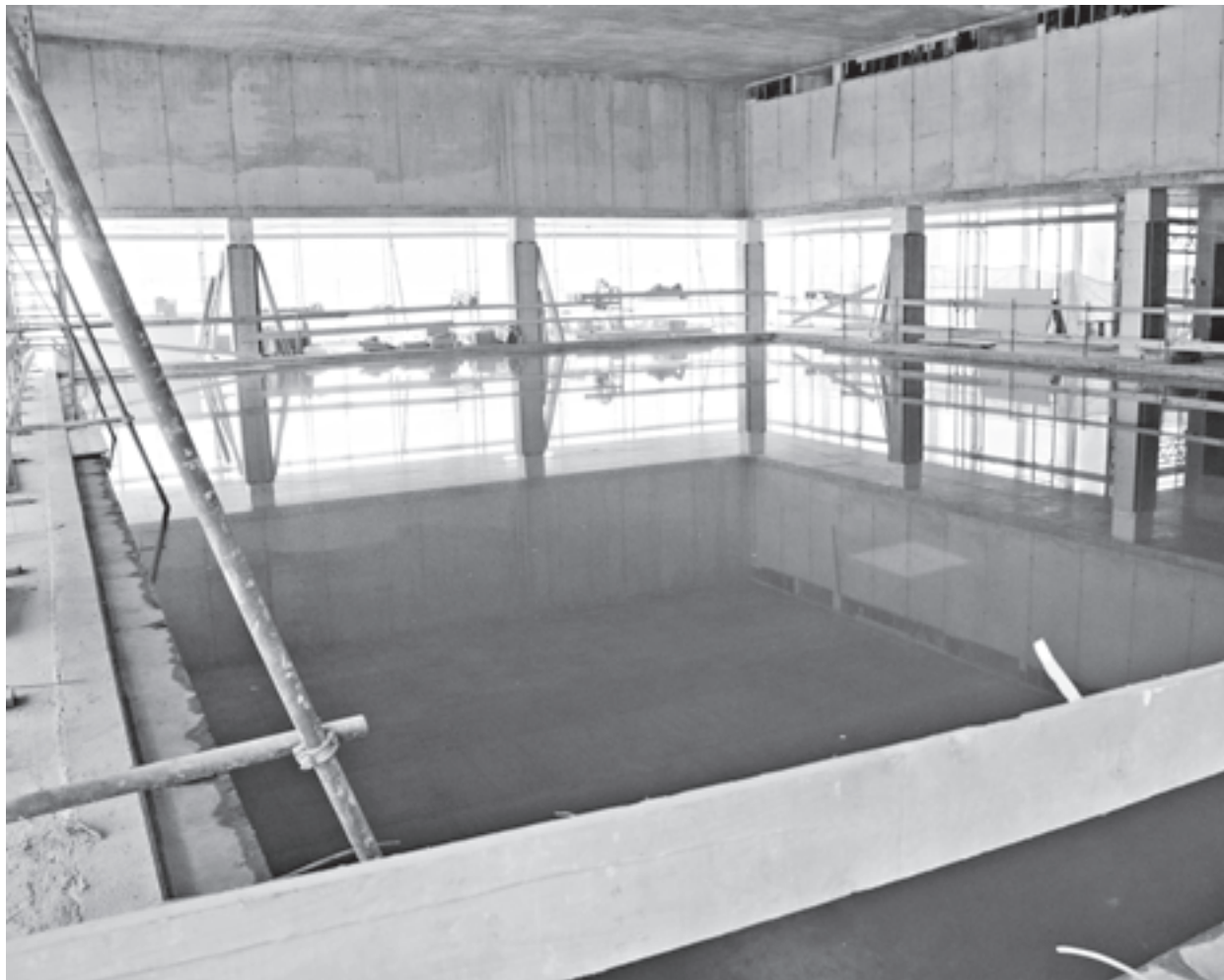
Test: Das grosse 25-Meter-Becken ist bereits mit Wasser gefüllt. Die Dichte des Beckens wird getestet. Rechts das künftige Entspannungsbad im Wellness-Bereich.
