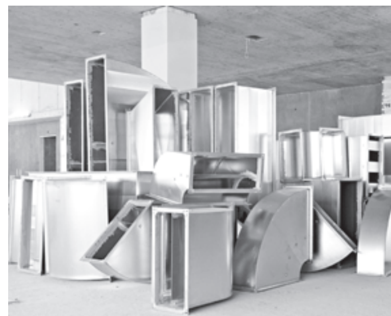
Die Lüftungselemente sind zum Einbauen bereit.
