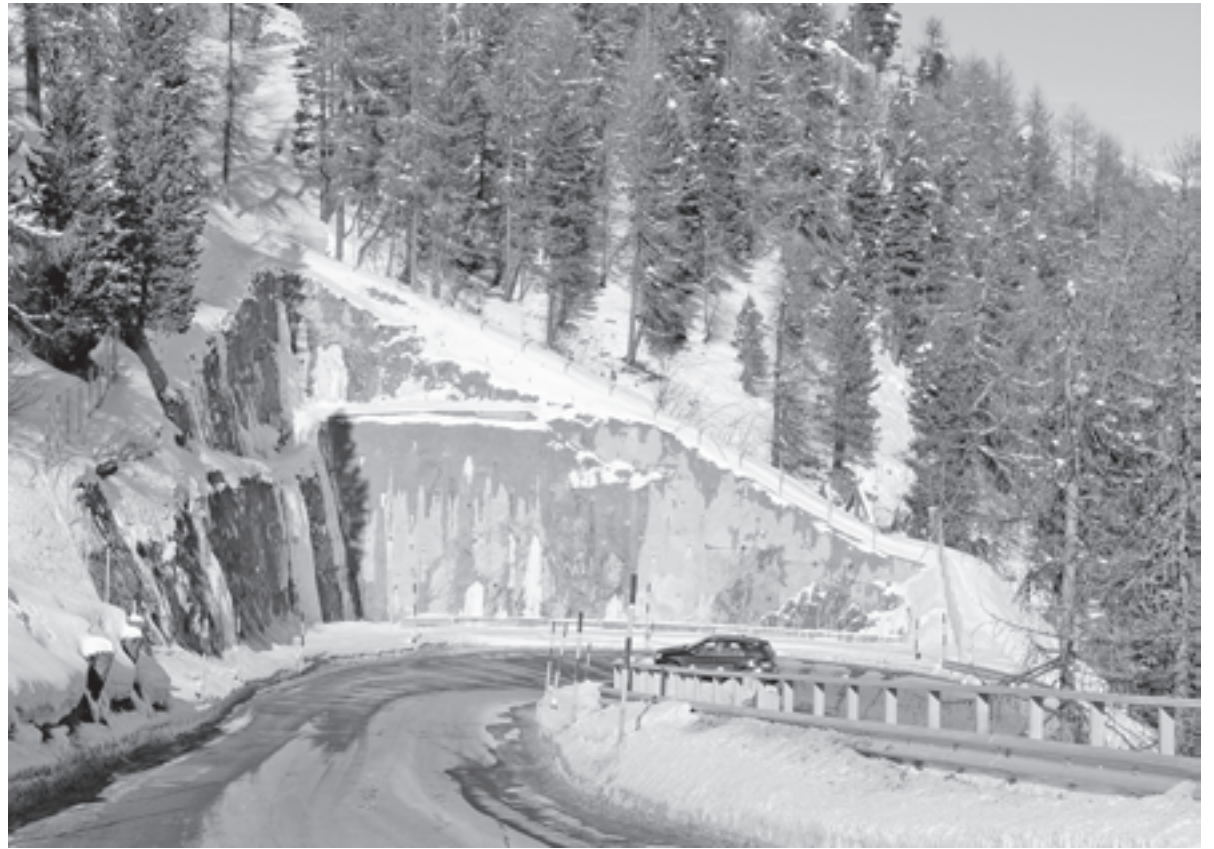
Hier bei der letzten Kurve vor Silvaplana erfolgt an der Julierstrasse ab Frühling 2013 der Anstich für den Bau des 750 Meter langen Tunnels im Rahmen der 1470 Meter langen Umfahrung.
