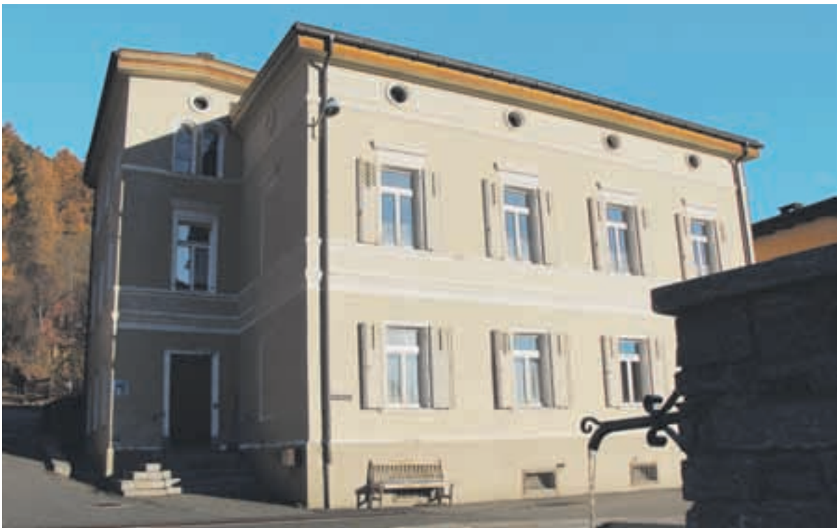
Das zwischenzeitlich leer stehende, gemeindeeigene Pfarrhaus soll als Leuchtturmprojekt für private Hauseigentümer vorbildlich saniert werden und für «Zernez Energia 2020» Werbung machen.
