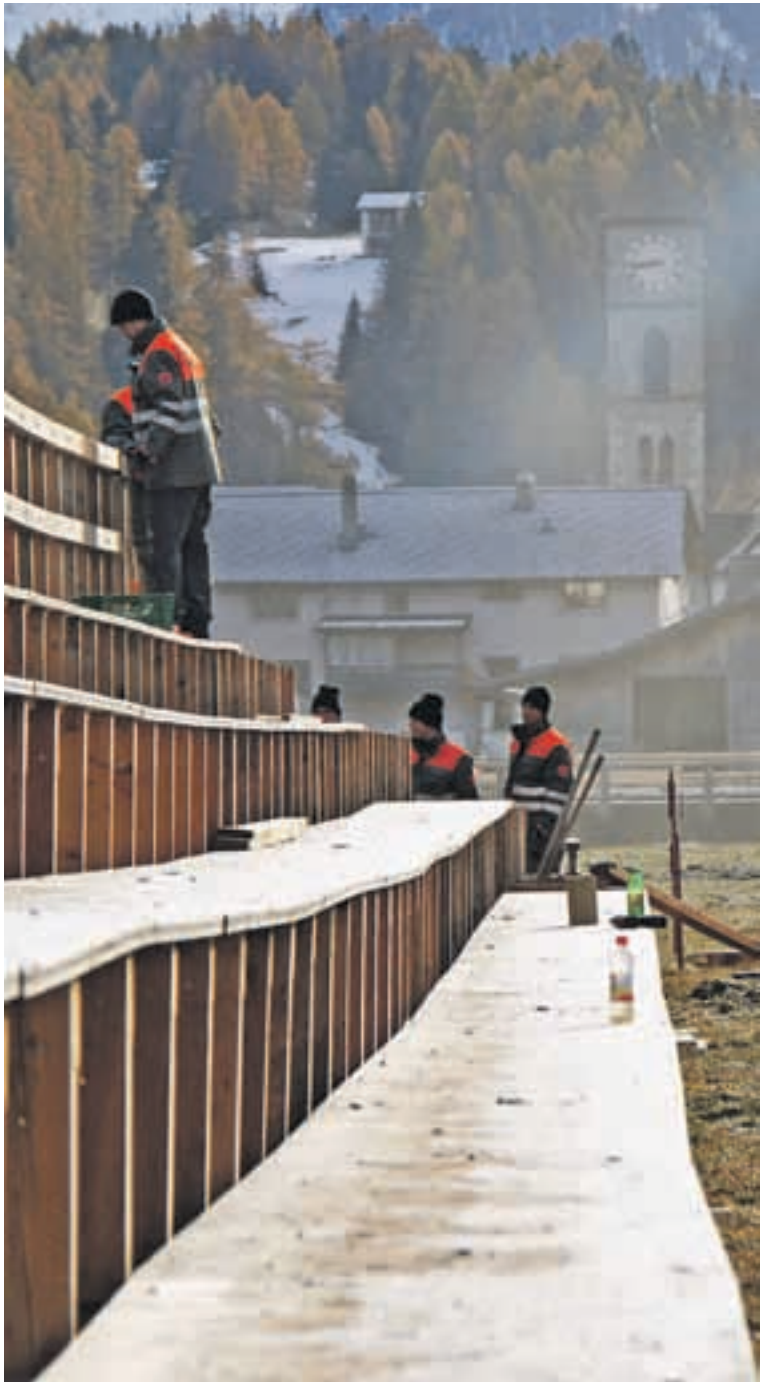
Die Aufbauarbeiten für die Tour de Ski sind im Gange. Foto: Jon Duschletta
