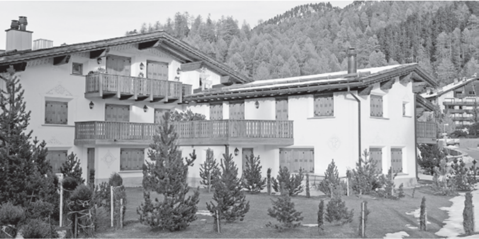
Für Franziska Preisig gibt es im Oberengadin viel zu viele Zweitwohnungen, es brauche keine einzige mehr. Leandro Testa betont, dass die Zweitwohnungsinitiative dem Bau von neuen Zweitwohnungen bereits einen Riegel schieben würde.
