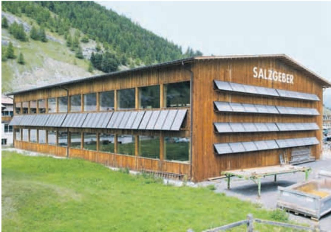
Sonnenenergie vom Dach und der Fassade des neuen Betriebsgebäudes unterstützt in S-chanf die Fernwärmeheizung der Firma Salzgeber Holzbau. Foto: Schweizer Solarpreis 2012
