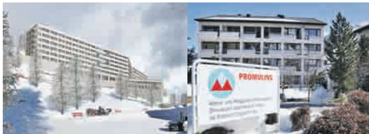
Sanierung und Ausbau Promulins (rechts) oder Neubau «Farkas»? Diese Frage zum künftigen Oberengadiner Pflegezentrum wird übermorgen im Kreisrat diskutiert. Foto: Marie-Claire Jur/Modellfoto «Farkas»: Baumann Roserens Architekten
