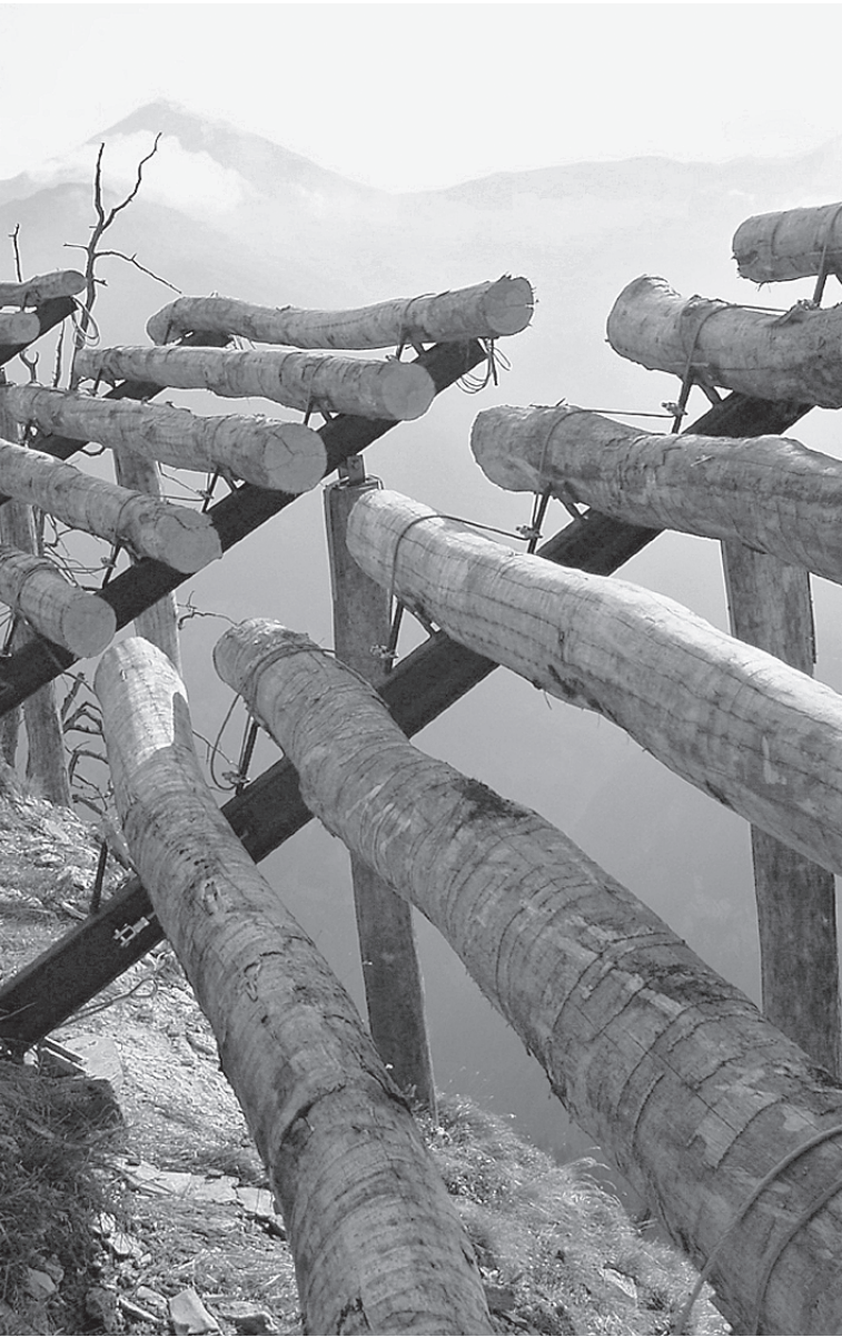
Der Kanton will 47 Schutzbauten mit Sanierungsmassnahmen erhalten.
