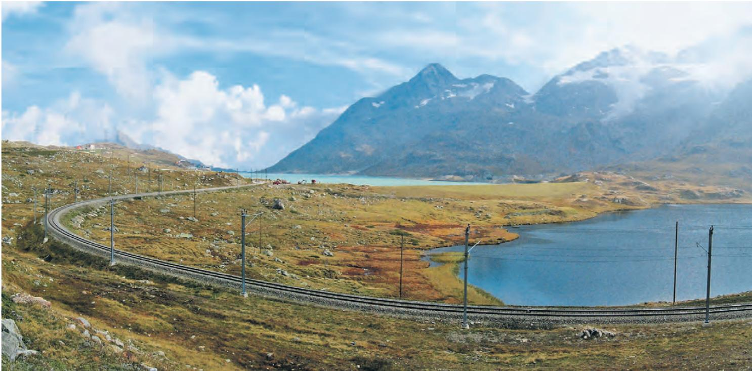
So wird nach der Erhöhung des Seespiegels um 4,35 m die Nordseite des Lago Bianco aussehen. Ohne Mauer, dafür mit einem begrünten Damm.
