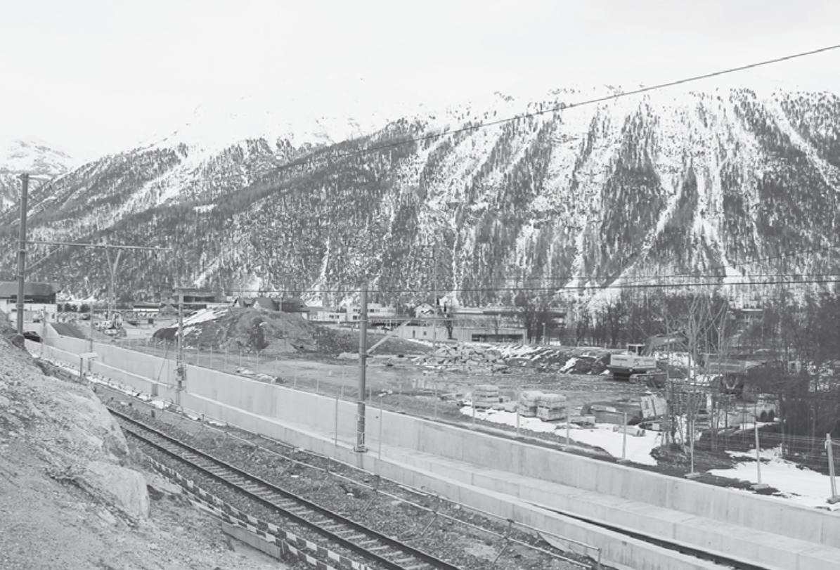
Auf diesem grossen Bauplatz, dem Areal Sper l’En in Samedan, sollen ein Hotel und Erstwohnungen entstehen. Das entsprechende Vertragswerk wurde am Donnerstagabend von der Gemeindeversammlung mit einer Ergänzung genehmigt.
