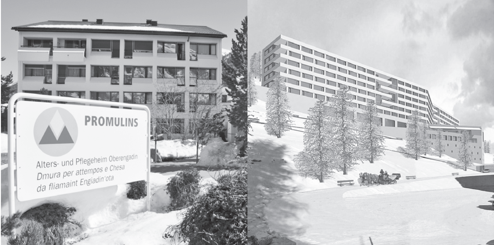
Sanierung und Ausbau Promulins (links) oder Neubau «Farkas» hinter dem Spital? Nach dem Entscheid des Kreisrates vom Donnerstag ist die Standortfrage vorübergehend wieder etwas in den Hintergrund getreten.
