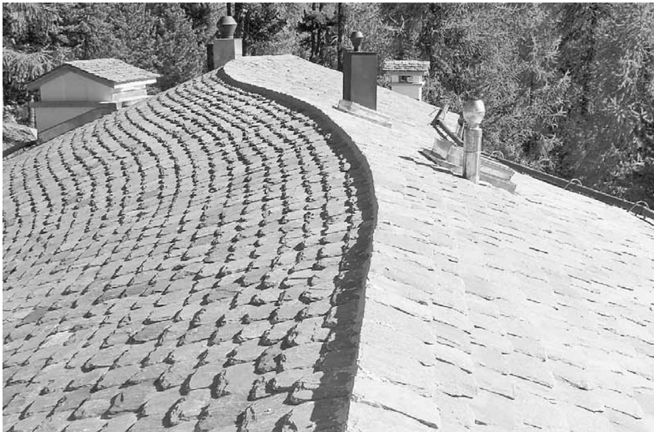
Eine sehr schöne Naturstein-Dachkonstruktion an einem Haus in Suvretta.
