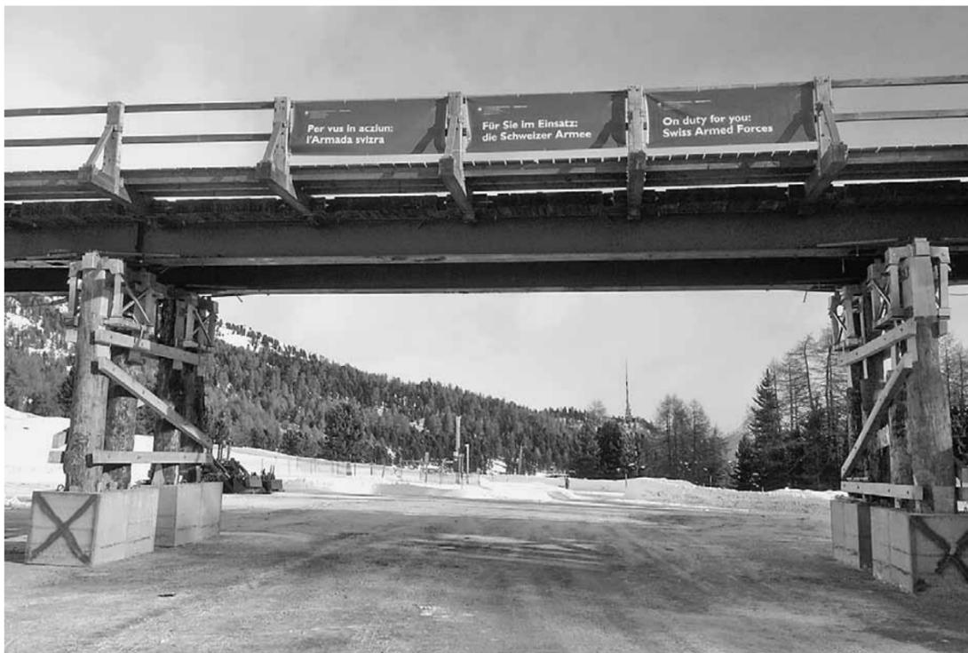
Von der Armee für den Weltcup gebaut: Die 40 Meter lange Stahlträgerbrücke.
