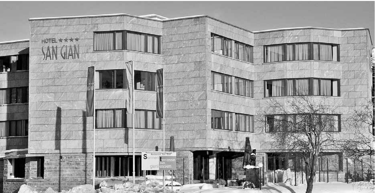
Neues Erscheinungsbild: Das Hotel San Gian in St. Moritz ist komplett saniert worden.
