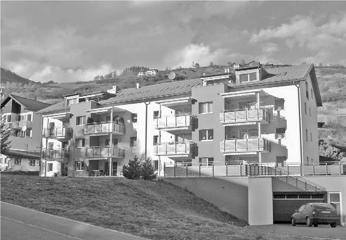
In üna part da la nouva chasa a Prasas-cher a Scuol vivan divers attempats in cumünanza.
