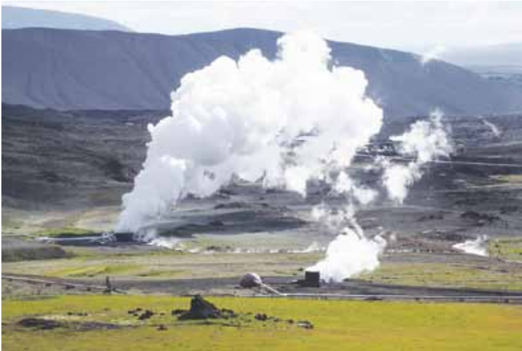
Volle Kraft voran: Geothermie – eine erneuerbare Energiequelle.
