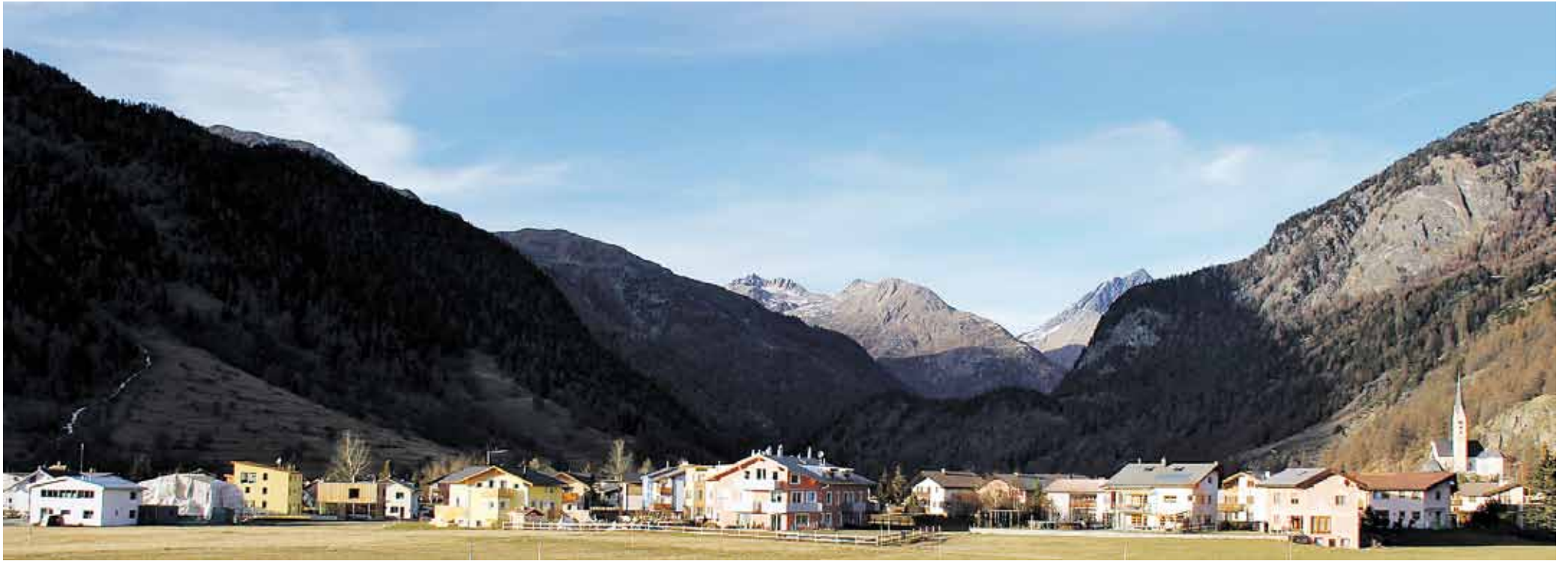
Das Gebiet Ruzön am Dorfrand von Zernez ist in den letzten Jahren entstanden. Nicht allen gefällt die kunterbunte Mischung von verschiedenen Baustilen.
