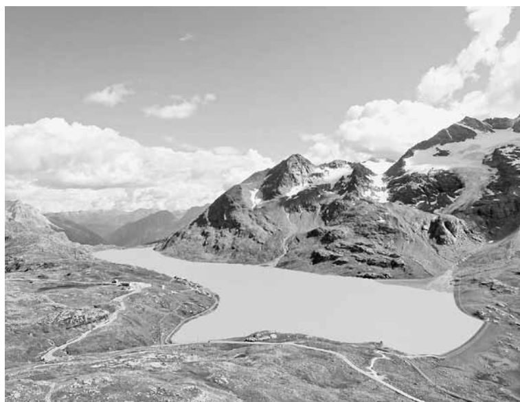
Für das geplante Pumpspeicherkraftwerk Lagobianco ist das Konzessionsgenehmigungsgesuch eingereicht worden. Am Lago Bianco sind verschiedene Massnahmen aus umweltschützerischer Sicht notwendig.
