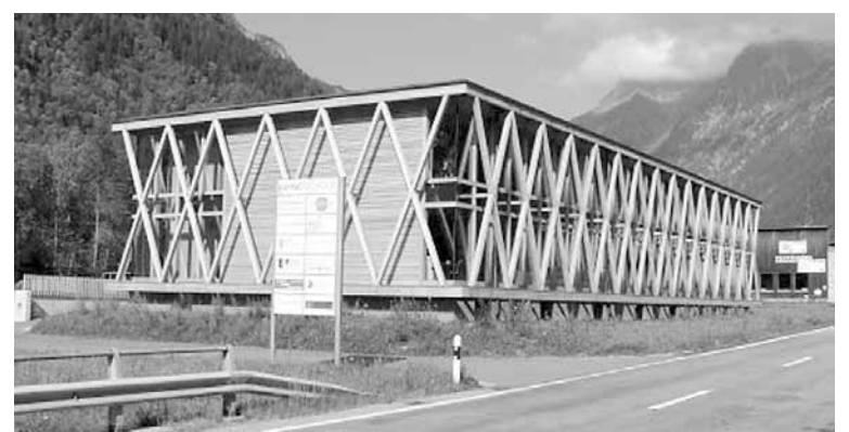
Die neue Raiffeisen-Bank befindet sich im Centro puntoBregaglia in Vicosoprano.
