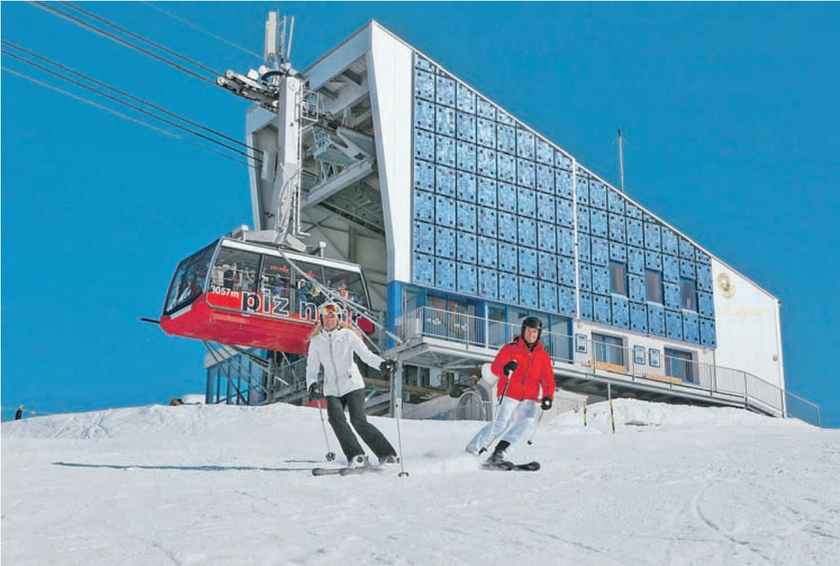
Nachhaltigkeit ist für immer mehr Wintersporttouristen von Bedeutung. Das lässt die Touristiker und Bergbahnen nicht kalt. Sie setzen deshalb auch auf Solarstrom- und Photovoltaik, wie hier bei der Talstation der Piz-Nair-Bahn. Foto: Swiss-image/Christof Sonderegger
