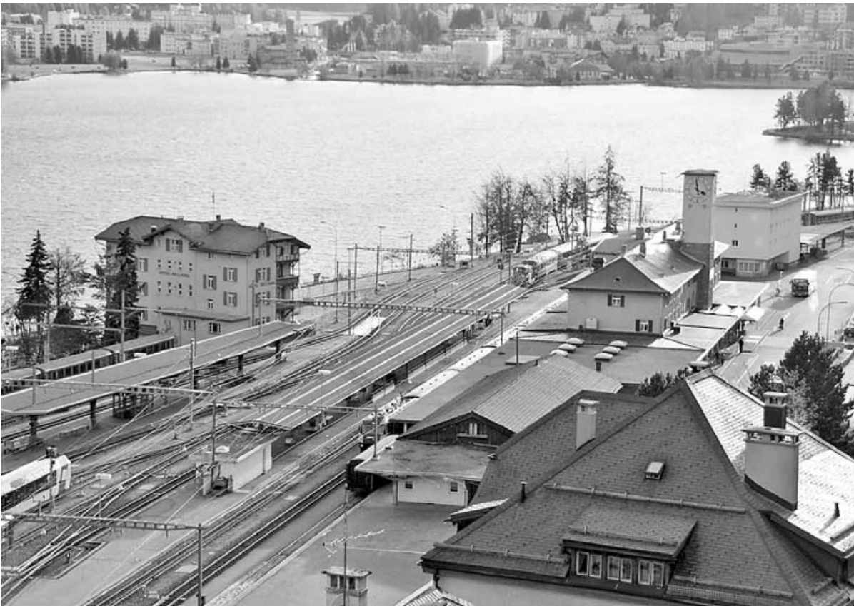
Auf 2017 in neuem Kleid? Der Bahnhof St. Moritz soll saniert und umgebaut werden.
