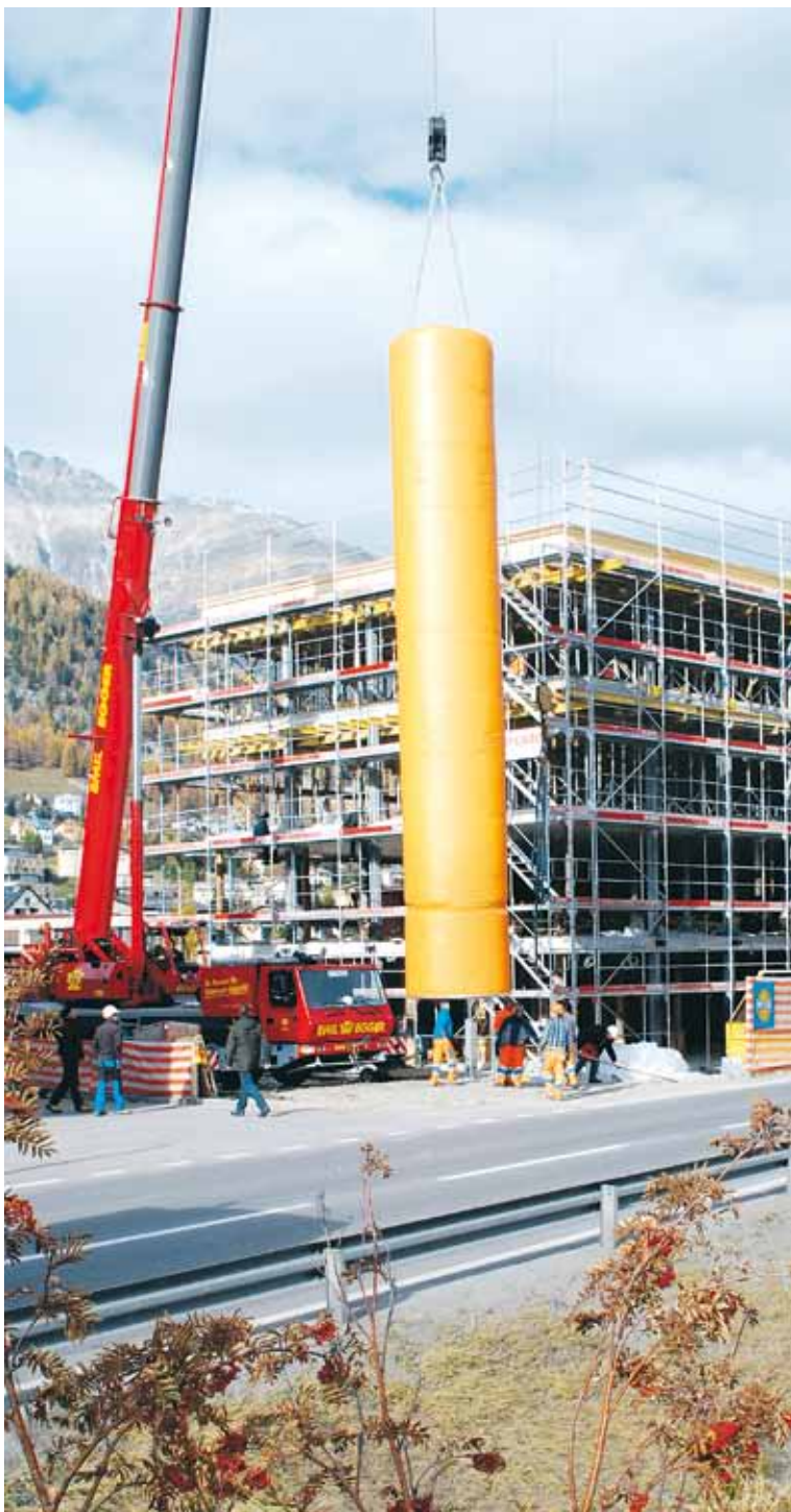
Anlieferung des Wassertanks, der 20 000 Liter umfasst.
