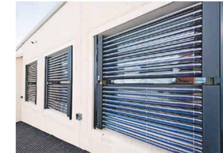
Fenster-integrierte Röhrenkollektoren. Diese liefern die Energie für das Warmwasser.
