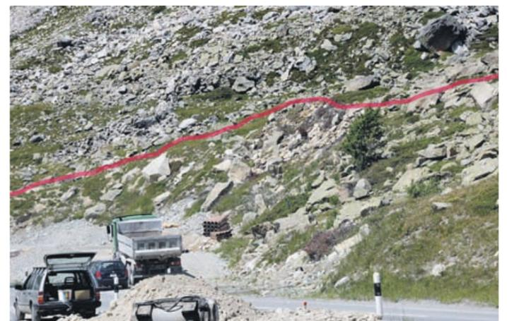
Eine neu eingesetzte, zurückversetzte Böschung mit Bodenmaterial, Rasenziegeln und Blöcken (unterhalb der roten Linie).
