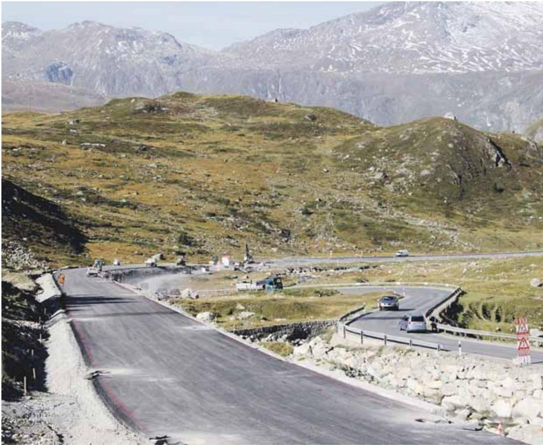
Der Neubauabschnitt Gelgia-Eva Cheda am Julierpass: Die abgetragenen Böden und Böschungen (links) werden nach Fertigstellung des neuen Trassees auf den alten, zurückzubauenden Strassenabschnitt (rechts) umgelagert.
