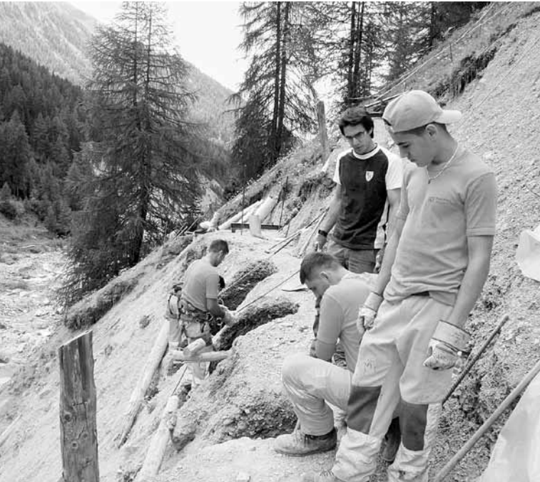
Einsatz in abschüssigem Gelände. Lernende des Tiefbauamtes der Stadt Zürich leisten eingangs des Val Trupchuns Instandstellungsarbeiten.
