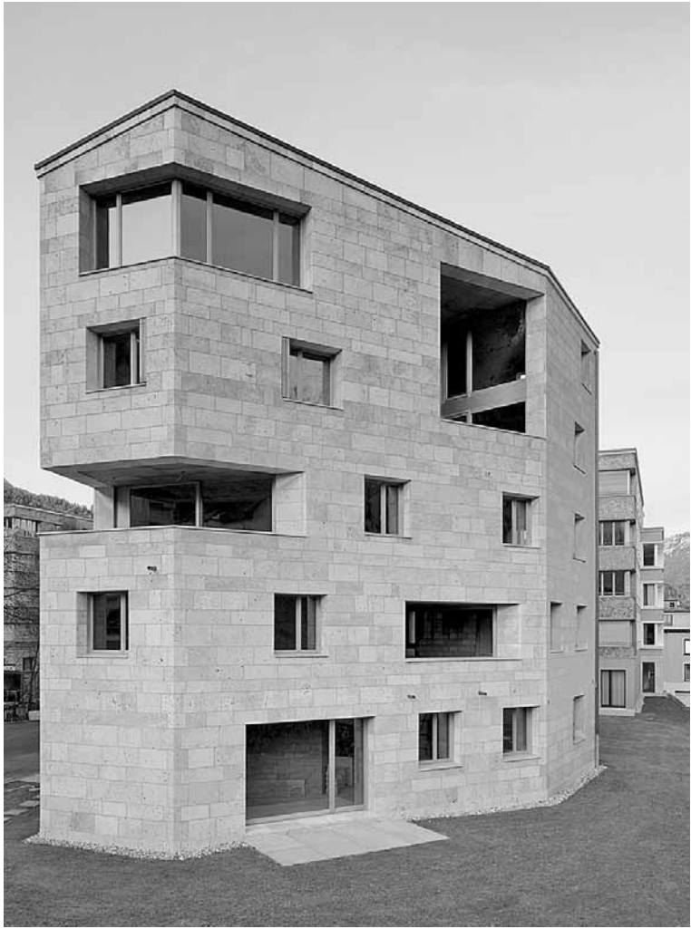
Hat der Jury gefallen: Die Natursteinfassade des Mehrfamilienhauses in St. Moritz-Bad. Foto: Roger Frei
