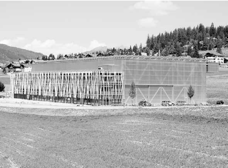
Auf dem Dach des auffälligen Gebäudes vor Savognin steht die grösste Photovoltaikanlage Graubündens.
