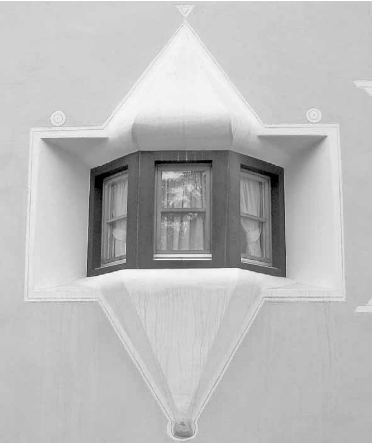
Dieser «Balcun Tort» verschwindet wegen einer Styropordämmungsschicht fast in der neuen Fassade.
