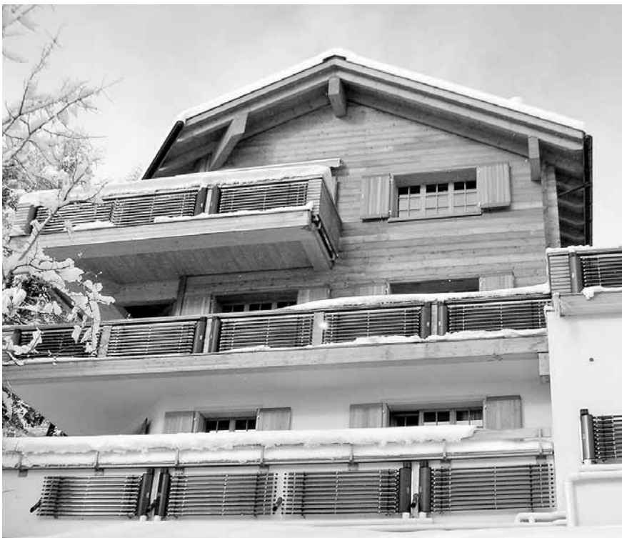
Das Gebäude an der Via Brattas 52–54, wo alle Balkongeländer mit waagrechten Schneefall-unabhängigen Solar-Vacuumröhren ausgerüstet wurden.
