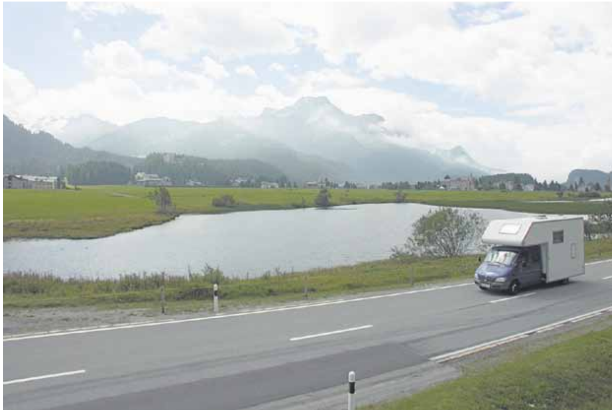
Heikelster Strassenabschnitt zwischen Sils und Maloja: Die Engadinerstrasse beim Lej Giazöl. Statt auf ihr soll bei Lawinengefahr der Verkehr über die Silser Ebene oder durch Sils Maria fließen, so der Kanton. Foto: Marie-Claire Jur
