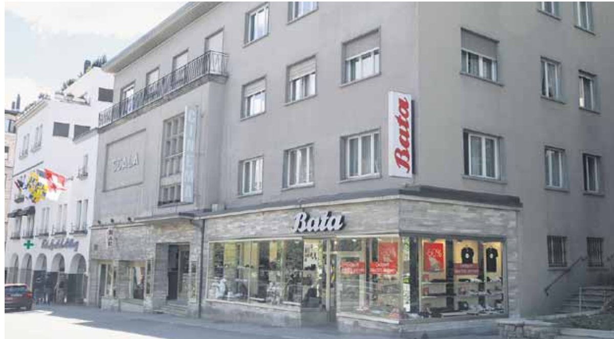
Das Gebäude mit dem Kino und der Scala-Bar soll 2012 oder 2013 abgerissen werden.
